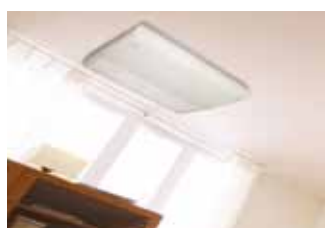
Установка под потолком
